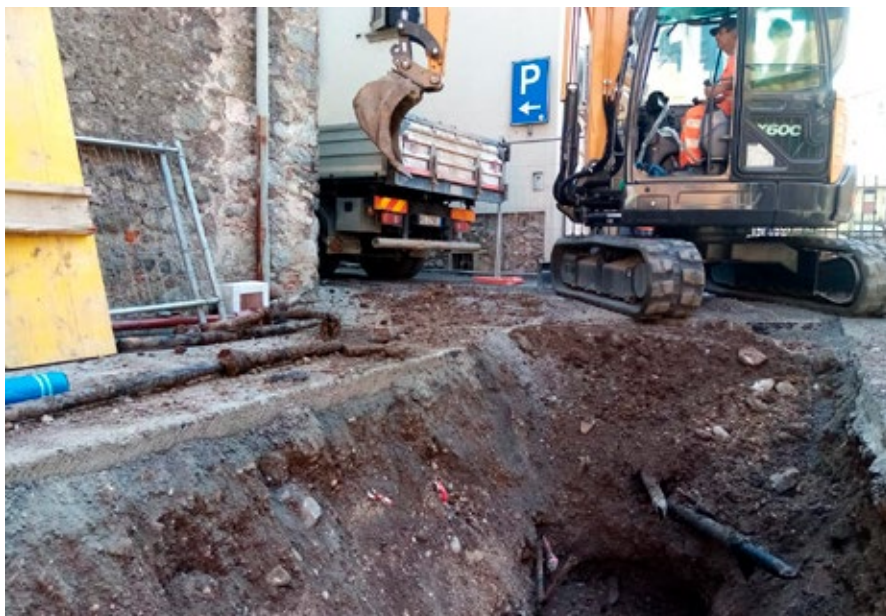
I lavori per la riqualificazione della rete fognaria in Via Parrocchiale
