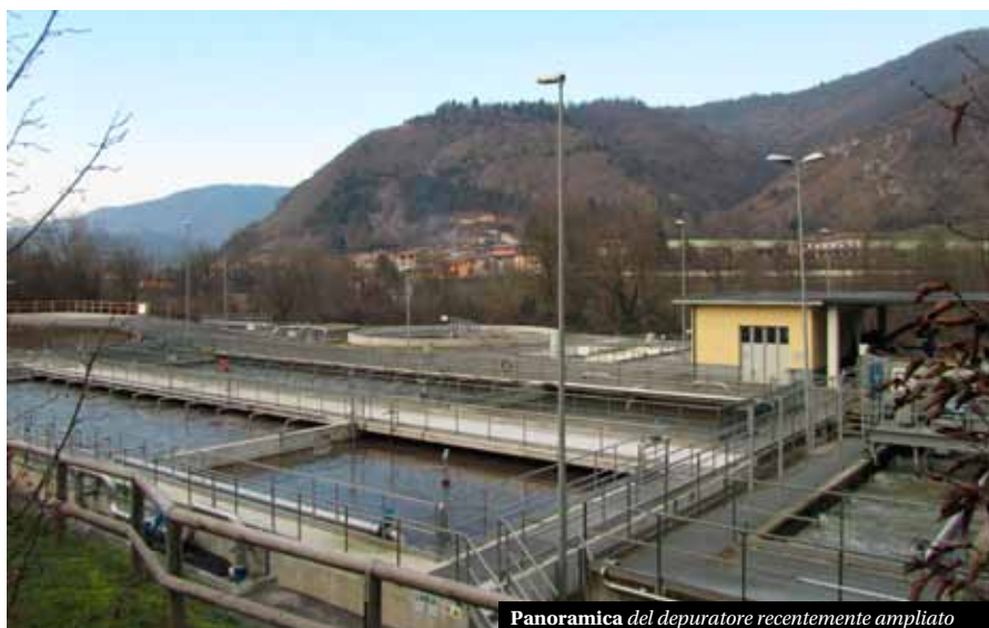
Panoramica del depuratore recentemente ampliato
