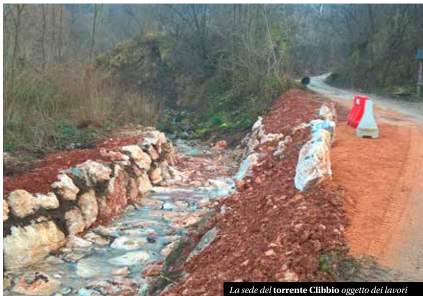
La sede del torrente Clibbio oggetto dei lavori
