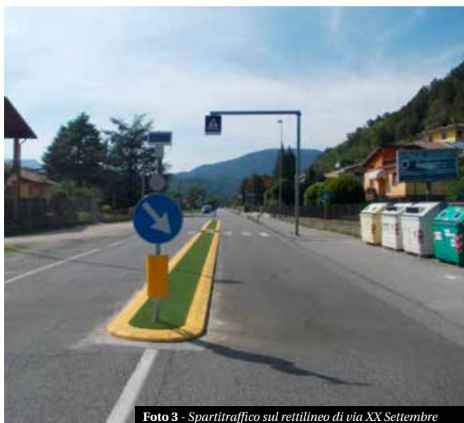
Foto 3 - Spartitraffico sul rettilineo di via XX Settembre
