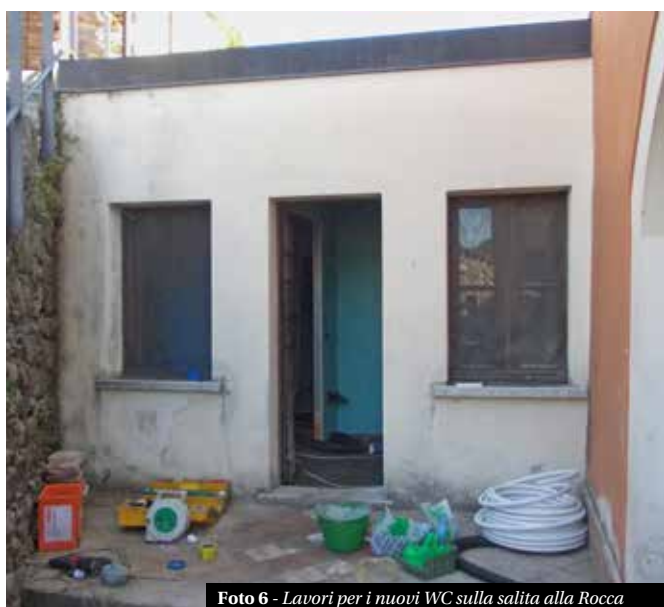
Foto 6 - Lavori per i nuovi WC sulla salita alla Rocca
