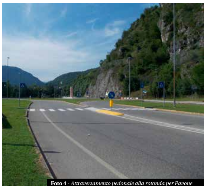
Foto 4 - Attraversamento pedonale alla rotonda per Pavone
