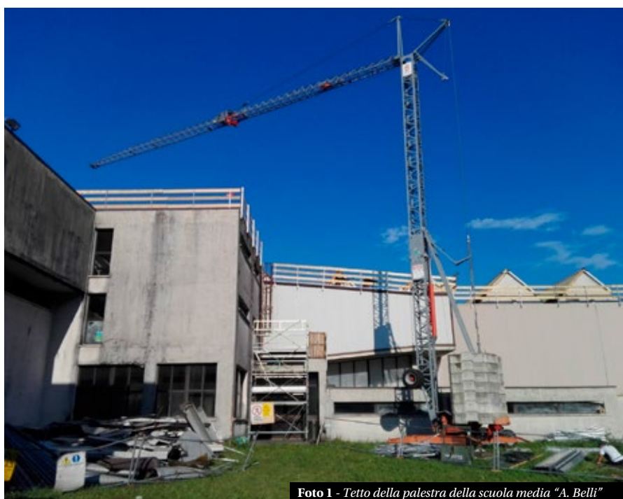
Foto 1 - Tetto della palestra della scuola media "A. Belli"
