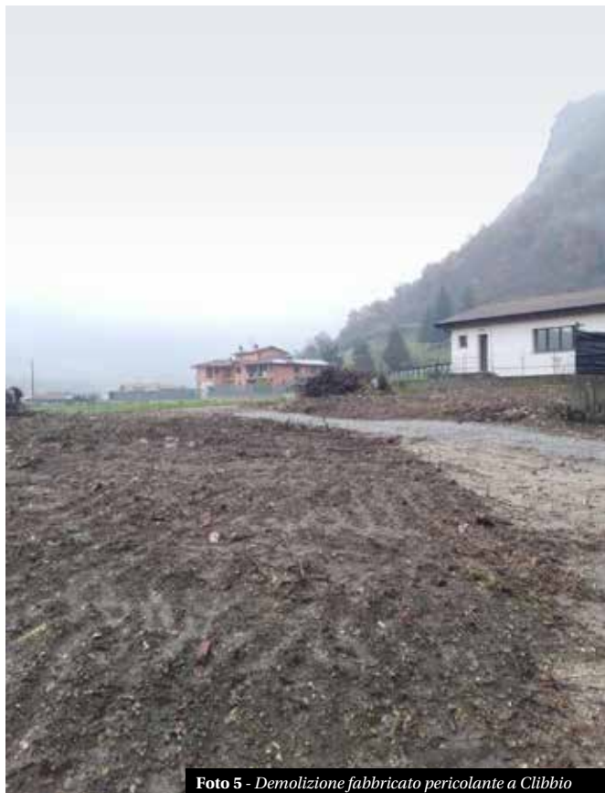
Foto 5 - Demolizione fabbricato pericolante a Clibbio
