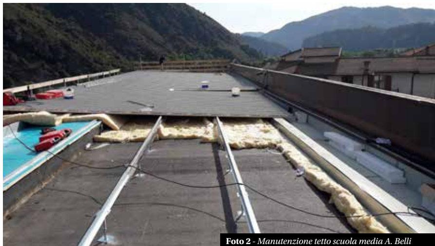
Foto 2 - Manutenzione tetto scuola media A. Belli
