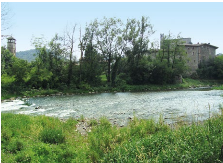
Il punto sul fiume Chiese dove il progetto prevederebbe la creazione della centralina
